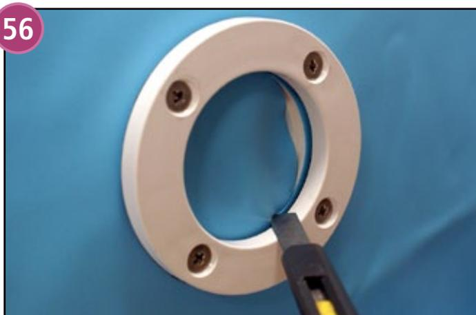
Efectue el recorte de la boquilla de retorno. Con un cutedor, recorte con precaución el liner, apoyándose en el interior del cuerpo de la boquilla
