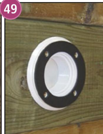
Coloque, por el lado vaso, el cuerpo de de la boquilla (Pack piezas para empotrar) de retorno en el orificio de la pared perforada.
