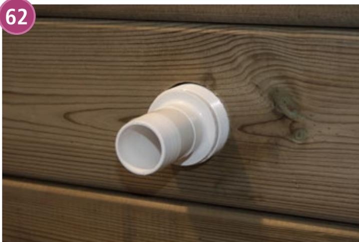
Empalmar el tubo de retorno del filtro en el r cord acanalado de la boquilla de retorno y fijarlo con un collar de ajuste.
