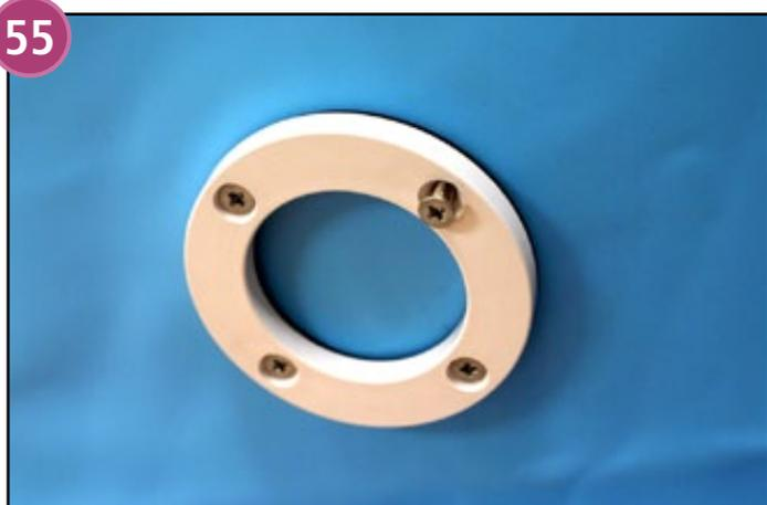
Atornille la brida equipada de su junta adhesiva mediante los tornillos de acero inoxidable FZ M5x16 del skin piezas para empotrar. Vigile que efectúe una presión alternada con el fin de garantizar una impermeabilidad perfecta. Privilegie una presión manual para evitar una presión demasiado brutal que podría hender la brida
